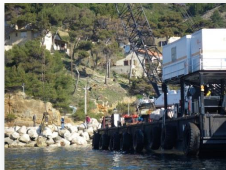
Confortement de la digue du port de la Redonne en mars 2011. (Photo : E. Charbonnel/PMCB).
